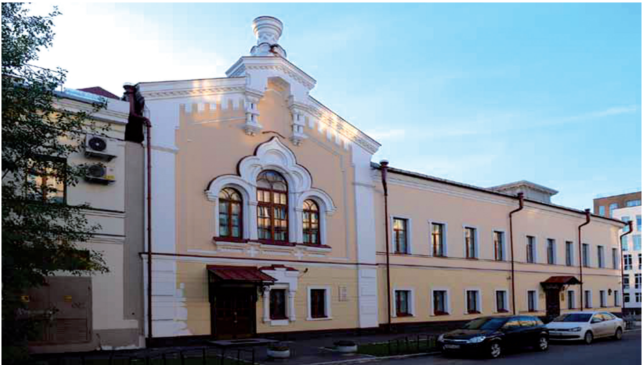
Здание Делового центра на улице Фукса в г. Казани
