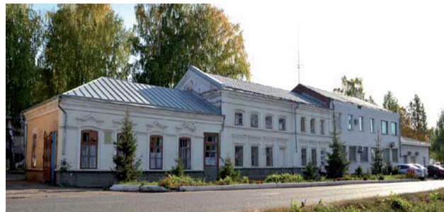
Комплекс зданий городской больницы (больничный городок). Улица К. Маркса, дом 59 (г. Чистополь)
