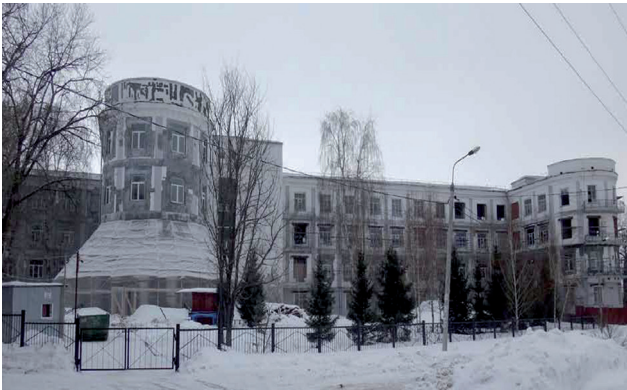
Здание 5-й городской клинической больницы до реконструкции
