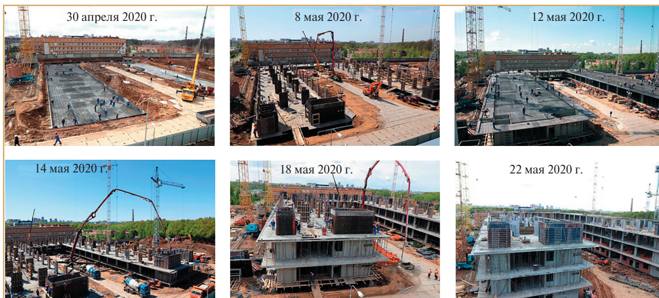
Этапы строительства нового корпуса РКИБ
